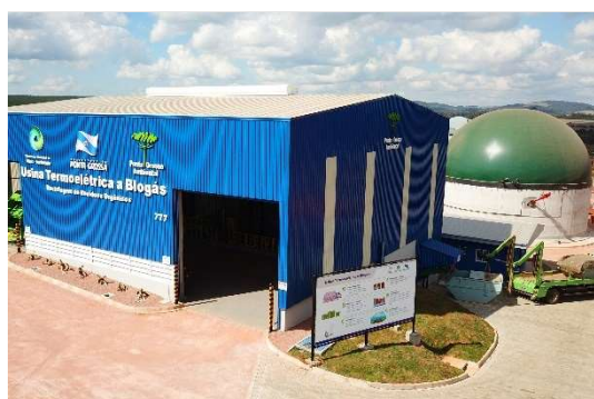
Figura 10 – Usina Termelétrica a Biogás (UTB)
